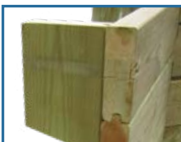
Alignez la console au sommet du madrier.
