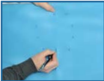
Repérez et tracez l'emplacement des vis.
