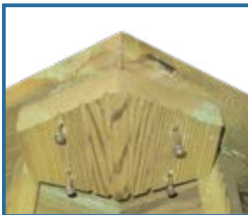
Fixation de la plaque sous margelles.
