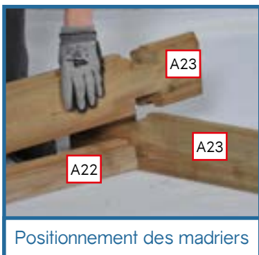
A l'aide d'un maillet, frappez sur la cale en bois pour emboîter à fond les madriers.
