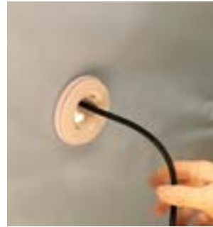
Passez le câble du projecteur par l'intérieur de la piscine
