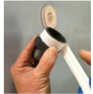
Mettre du téflon sur le raccord fournis pour faire l'étanchéité
