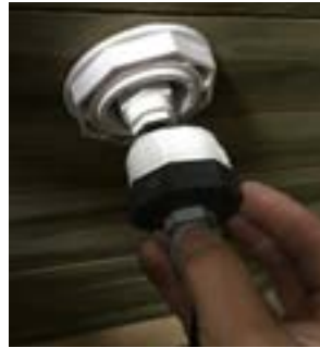
Placez le bouchon à l'extérieur de la piscine sur le corps de buse
