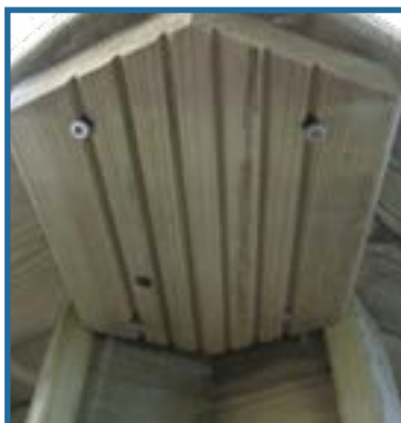
Fixation de la plaque sous margelles.
