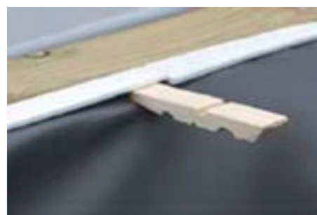
Figure 28 - Verrouillage du liner grâce à des demi épingles à linge
