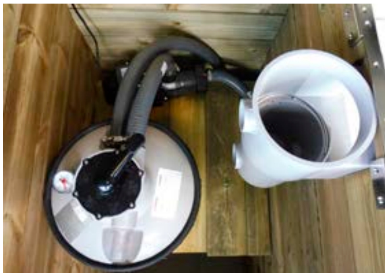
Figure 25 - Connexion du système de filtration Filtre / Pompe / Aspiration / Refoulement
