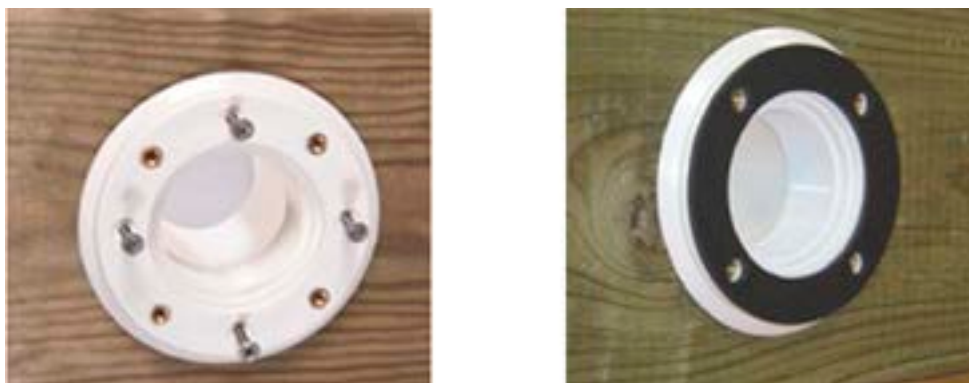
Figure 24 - Montage du corps de la buse de refoulement et de son joint
