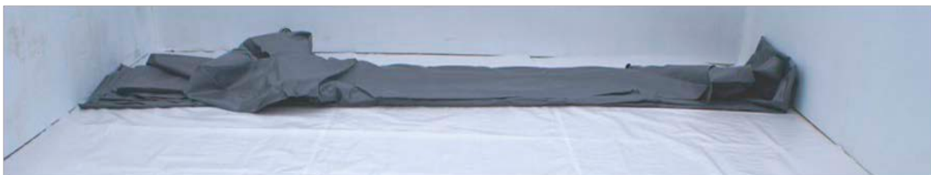
Figure 27 - Dépliage du liner
