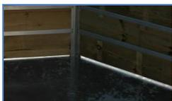
**IMPORTANT :** Essayer le rail aluminium sur les panneaux avant montage pour vérifier qu'il n'y a pas de bavure.
