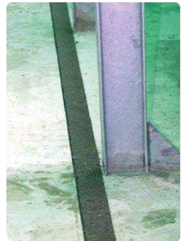
Figure 8 – Mise en place des bandes bitumeuses
