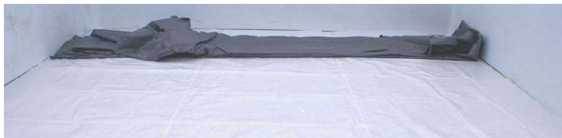
Figure 32 – Dépliage du liner
