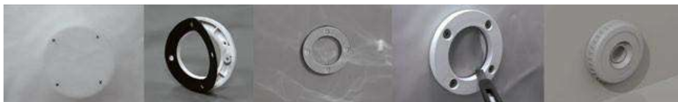
Figure 34 – Montage de la bride sur le refoulement
