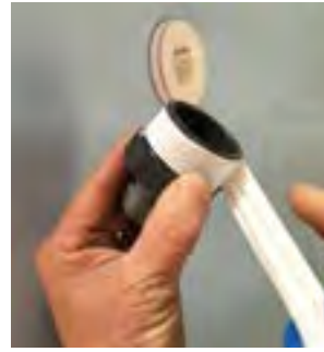
Mettre du téflon sur le raccord fournis pour faire l'étanchéité
