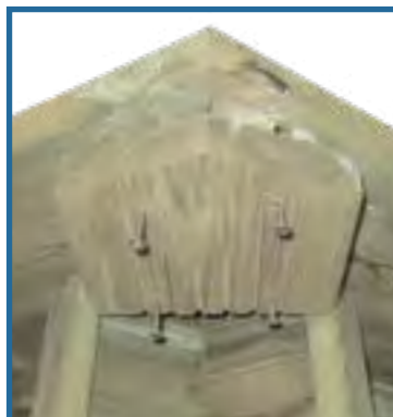
Fixation de la plaque sous margelles.
