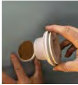
Maintenez le joint sur le liner et positionnez le corps de buse avec l'adaptateur
