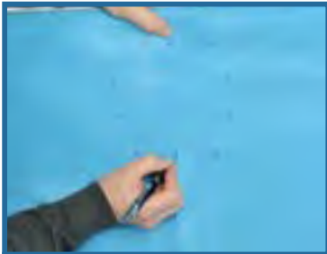
Repérez et tracez l'emplacement des vis.
