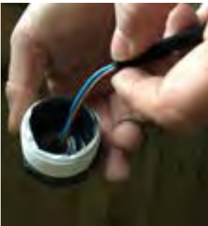
Faites passer le câble du projecteur dans le trou du raccord et dans le presse étoupe
