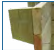
Alignez la console au sommet du madrier.
