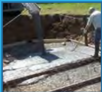
Réalisation de la dalle béton
