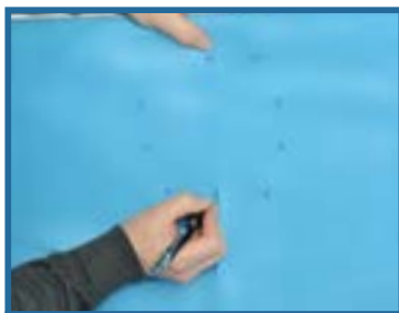
Repérez et tracez l'emplacement des vis.
