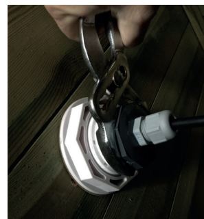
Serrez le raccord à l'aide d'une pince
