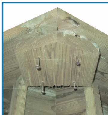
Fixation de la plaque sous margelles.
