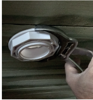
Serrer à l'aide d'une pince d'une écrou
