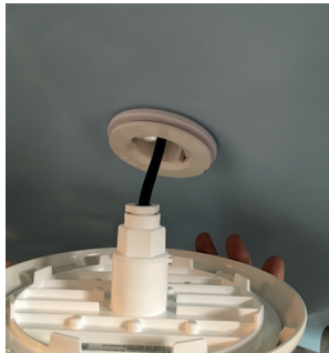
Serrer à l'aide d'une pince d'une écrou
