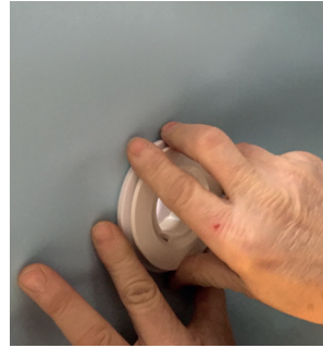
Positionnez la buse et la maintenir
