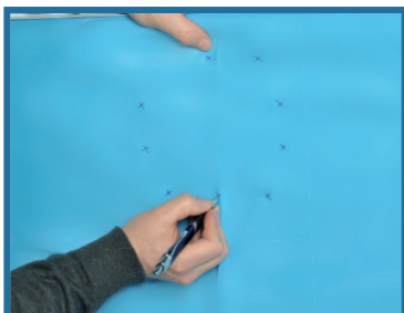
Repérez et tracez l'emplacement des vis.
