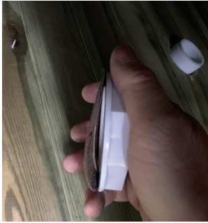
Prendre l'écrou et le joint en liège, a positionner à l'arrière de la buse
