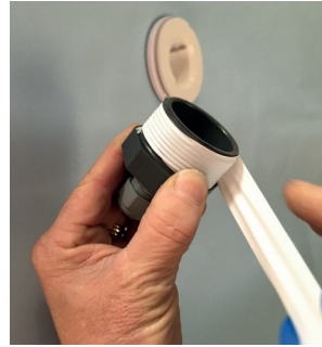
Mettre du téflon sur le raccord fournis pour faire l'étanchéité
