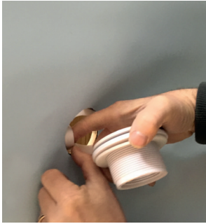
Faire glisser le joint entre la parois (+ feutre) et le liner
