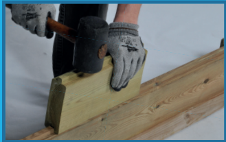
À l'aide d'un maillet, frappez sur la cale en bois pour emboîter à fond les madriers.
