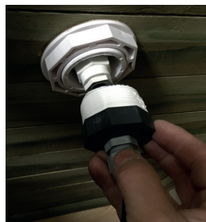
Placez le bouchon à l'extérieur de la piscine sur le corps de buse
