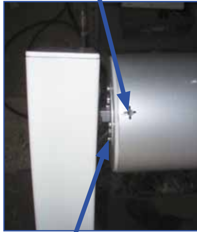
Lubrifier sur l'extrémité de la bague
