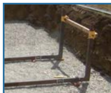
Maintenez l'aplomb des montants verticaux pendant la prise du béton.
