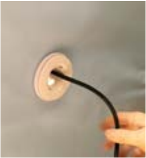
Passez le câble du projecteur par l'intérieur de la piscine
