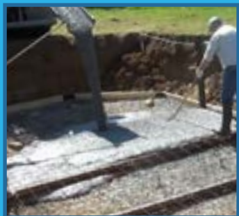
Réalisation de la dalle béton
