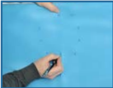
Repérez et tracez l'emplacement des vis.
