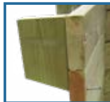
Alignez la console au sommet du madrier.
