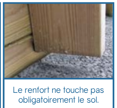
Assemblez le renfort en mettant une vis par madrier.
