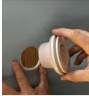
Maintenez le joint sur le liner et positionnez le corps de buse avec l'adaptateur
