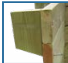
Alignez la console au sommet du madrier.
