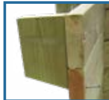
Alignez la console au sommet du madrier.
