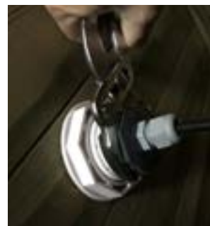
Serrez le raccord à l'aide d'une pince
