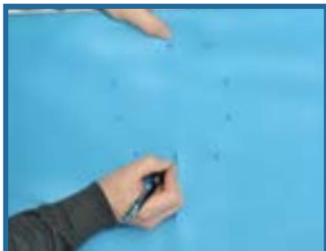
Repérez et tracez l'emplacement des vis.
