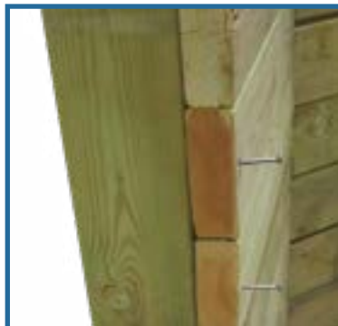
Assemblez le renfort en mettant une vis par madrier.
