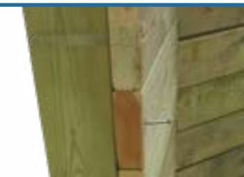
Assemblez le renfort en mettant une vis par madrier.
