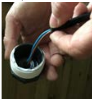
Faites passer le câble du projecteur dans le trou du raccord et dans le presse étoupe
