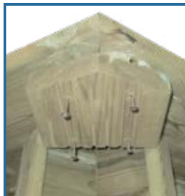
Fixation de la plaque sous margelles.
