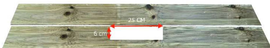
Découper la margelle arrière pour passage des tuyaux PHOTO 2
