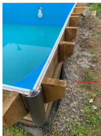
Fixation des plaques sur le dessus PHOTO 1
