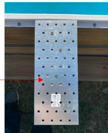
Fixation des plaques sur le dessus PHOTO 1
