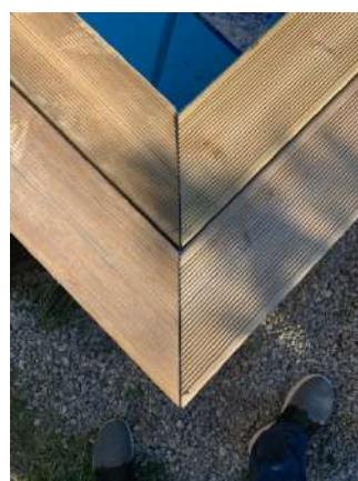
Positionnement des margelles en laissant un petit espace de 5 a 10 mm
