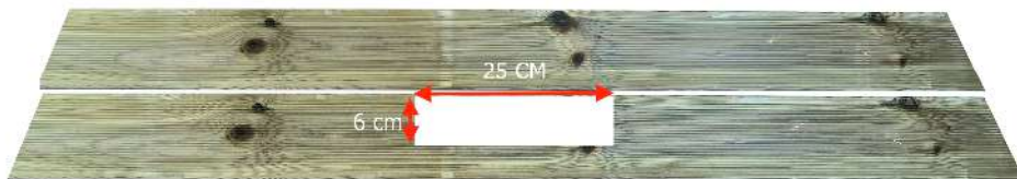
Découper la margelle arrière pour passage des tuyaux PHOTO 2
