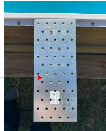
Fixation des plaques sur le dessus PHOTO 1
