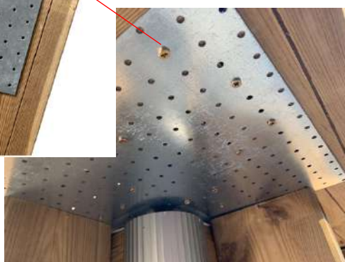
Fixer les plaques des angles par dessous PHOTO 3
