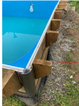
Fixation des plaques sur le dessus PHOTO 1
